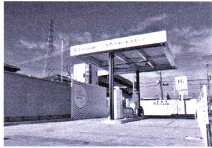
名古屋大高水素ステーション
